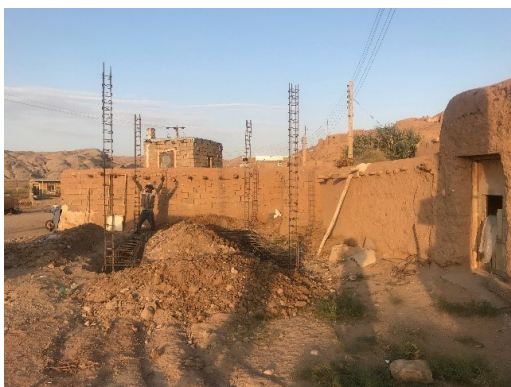
Baubeginn des Gebäudes der künftigen Trinkwasseraufbereitung (Bild: Dr. N. Bagherpour Kasani)
