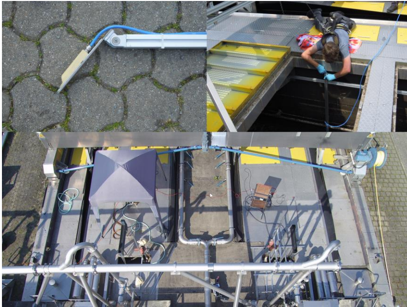
Oben links: Keilsensor vor dem Einbau; oben rechts: Einbau des Keilsensors unter erschweren Bedingungen; unten: Sandprobennahme an den Zulaufbereichen zweier Sandfänge (Bild: Steve Borchardt, FG Wasserbau)
